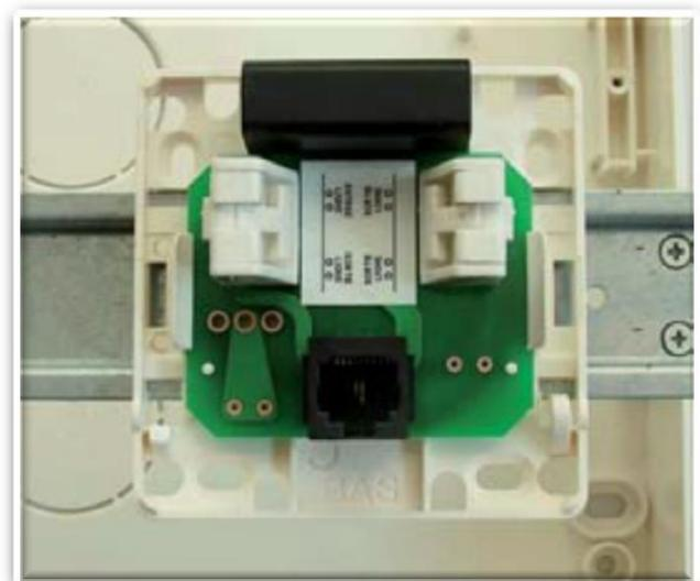
5. Enclenchez ou faites glisser le socle sur le rail DIN par le côté.
